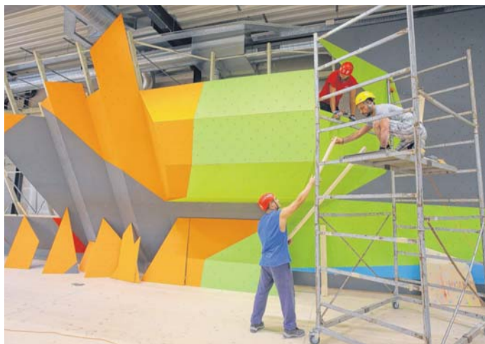
Die Wettkampfwand mit rund 250 Quadratmetern Kletterfläche ist mittlerweile so gut wie fertiggestellt. FOTOS: VN/HOFMEISTER
